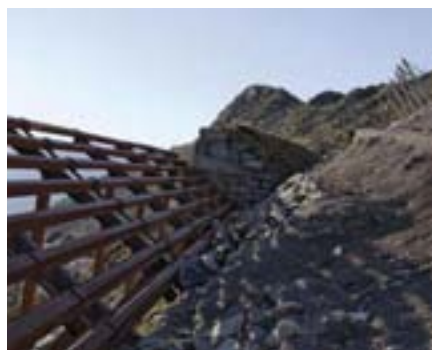
A la suite d'avalanches dévastatrices, les zones de déclenchement ont été largement équipées de paravalanches (NB).
