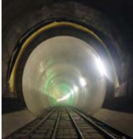
Pour des raisons de sécurité, le tunnel de base est constitué de deux tubes à une seule voie; ici, le tube près de Bodio présente encore deux voies de chantier (ATG).
